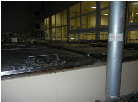
Trước khi thi công
