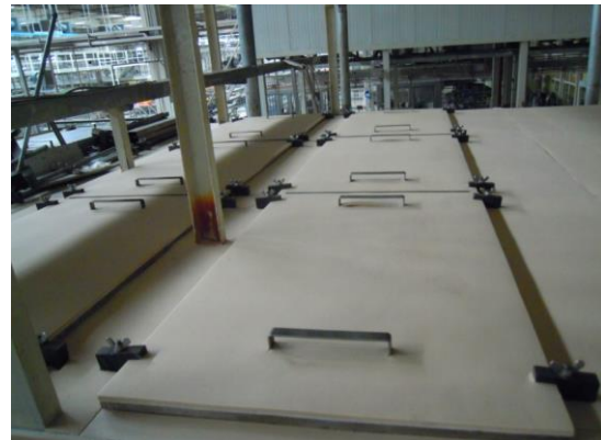
Sau khi thi công
