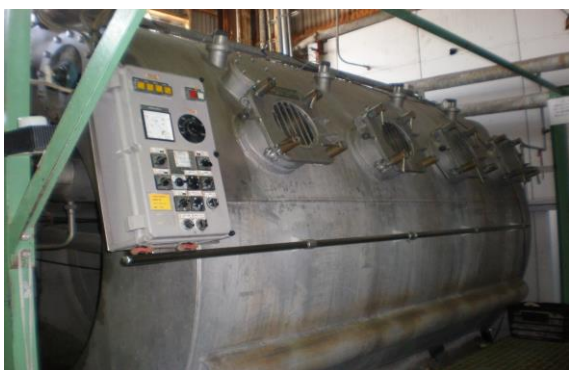
Trước khi thi công
