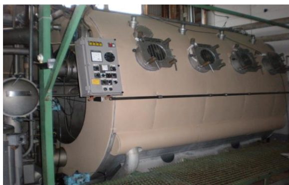
Sau khi thi công
