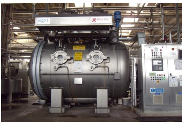
Trước khi thi công
