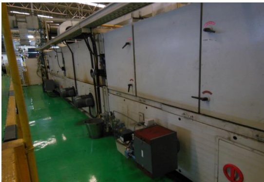
Trước khi thi công
