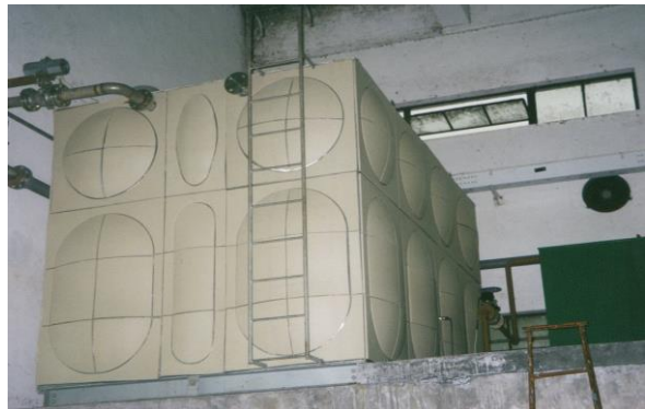
Sau khi thi công
