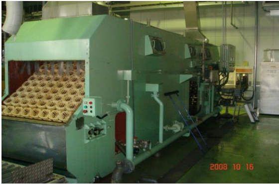
Trước khi thi công
