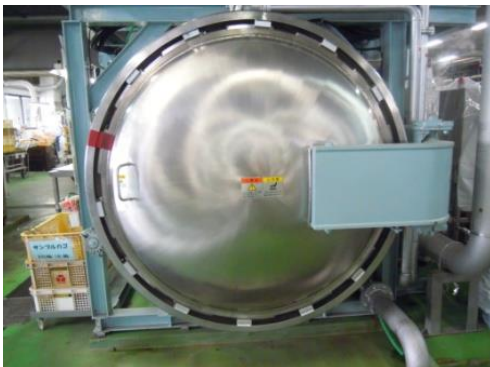
Trước khi thi công
