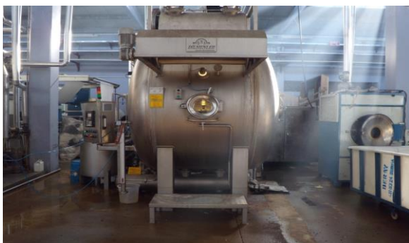
Trước khi thi công
