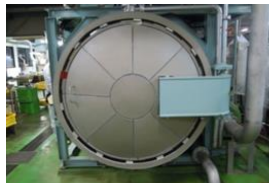
Sau khi thi công
