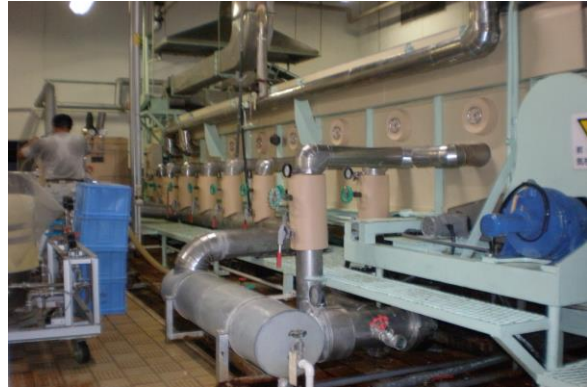
Sau khi thi công
