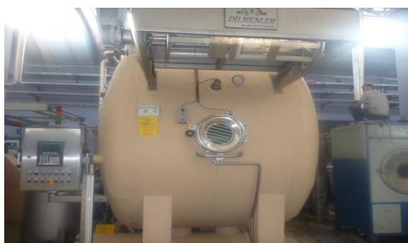
Sau khi thi công
