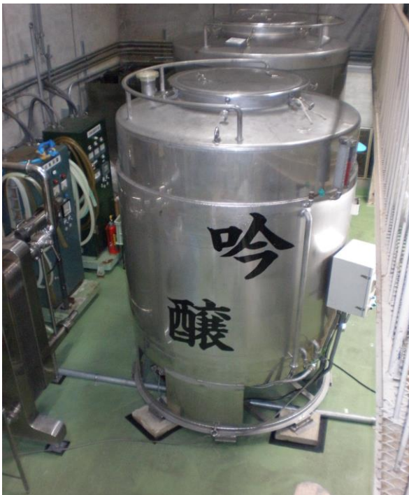
Trước khi thi công
