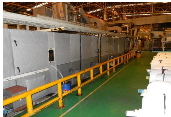
Sau khi thi công
