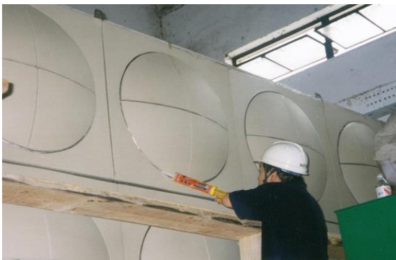
Trước khi thi công
