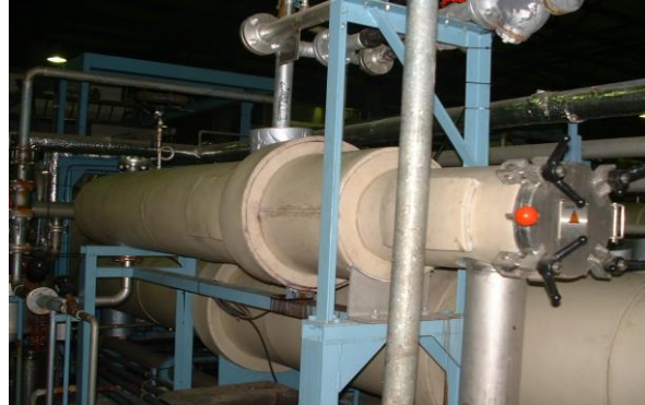
Sau khi thi công
