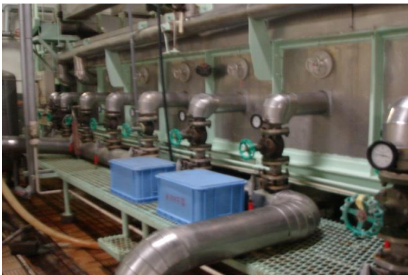
Trước khi thi công
