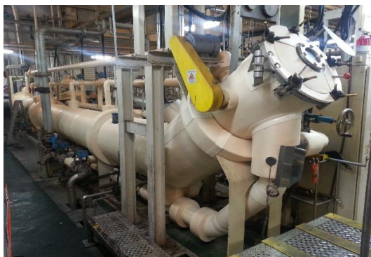
Sau khi thi công
