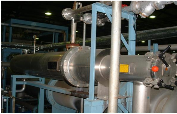
Trước khi thi công
